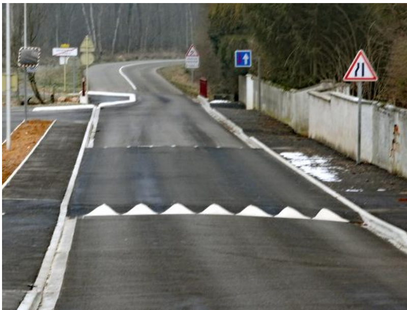
Plateaux rue de Damparis, mise en sécurité
