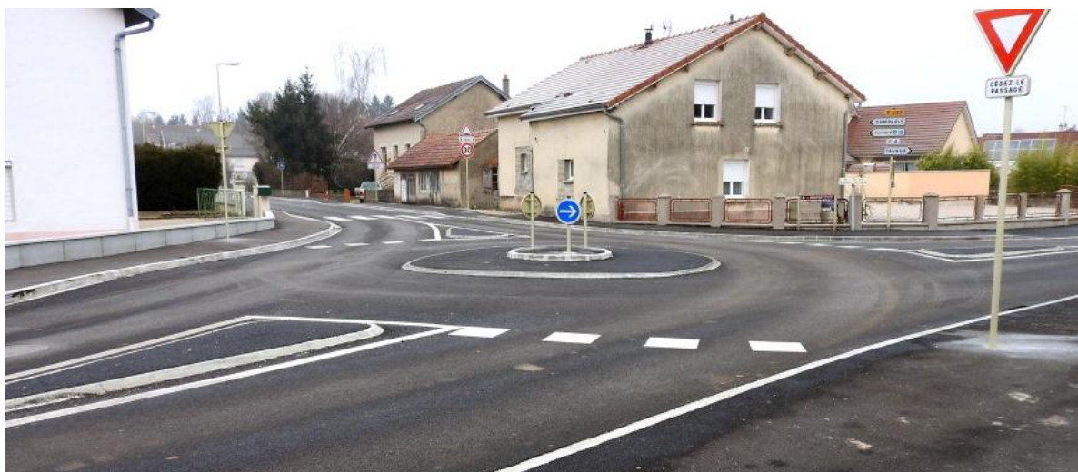
Rond-point rue du Centre et rue de Damparis après les travaux
